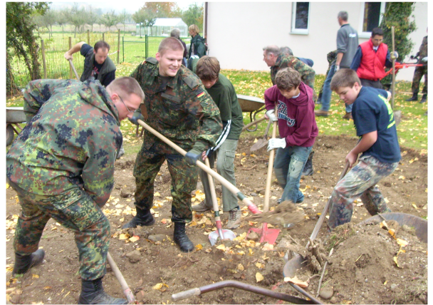
Teamwork: Angehörige der Wettkampfgruppe der Reservistenkameradschaft Singen und Jugendliche bei Aushubarbeiten für den neuen Kinderspielplatz der Heimsonderschule Mühlhausen
