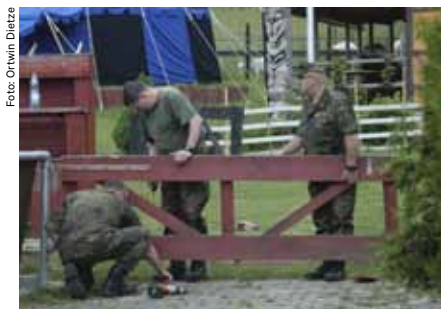
Bei den Reparaturen von Sturmschäden auf der Jugendfarm Böblingen brachten Reservisten ihr Fachwissen ein
