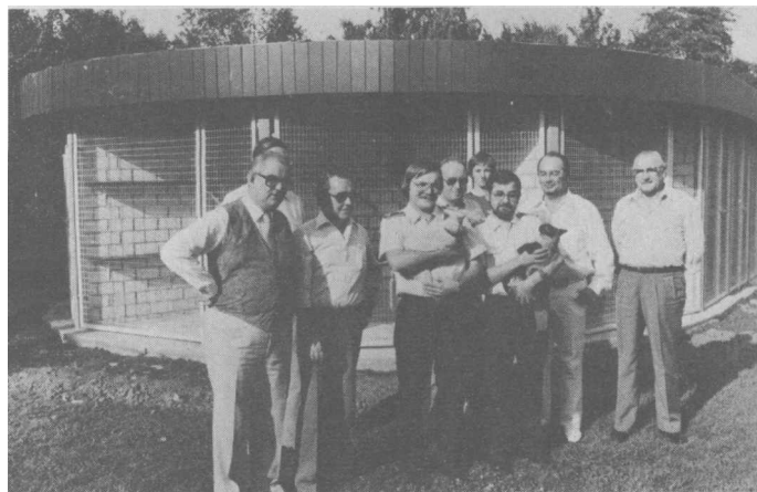
RESERVISTEN HALFEN DEM TIERSCHUTZ: Ein neues Katzenheim für mehrere Dutzend Katzen baute der Tierschutzverein Heidelberg und Umgebung e. V. auf dem Gelände seines Tierheimes. Für die Fertigstellung des Gebäudes stellten sich in mehreren hundert freiwilligen Arbeitsstunden Reservisten der RK Heidelberg zur Verfügung, die den Innenausbau und den Ausbau der einzelnen Boxen übernahmen. Der 1. Vorsitzende des Tierschutzvereins, Dr. Christ, stattete der RK Heidelberg seinen Dank ab. Der Einsatz der Heidelberger Reservisten fand auch in der örtlichen Presse seine gebührende Anerkennung. Unser Foto zeigt Oberfähnrich d.R. Henninger, StUffz d.R. Maier (beide in Uniform) sowie HptFw a.D./d.R. Bottler (in Zivil) bei der Einweihungsfeier inmitten der Vorstandsmitglieder des Tierschutzvereines Heidelberg vor dem neuerbauten Katzenheim.
