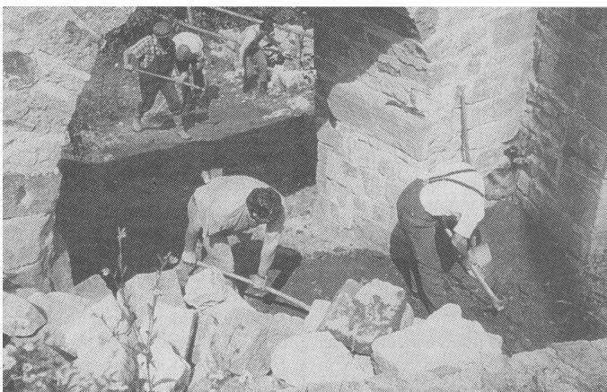
Auf der Kirnburg bei Bleichheim bauen Reservisten eine Treppe und einen Zugang zum Burginneren. Seit Jahren beteiligen sich Freiburger und Breisgau-Unteroffiziere der Reserve an diesem Projekt.
